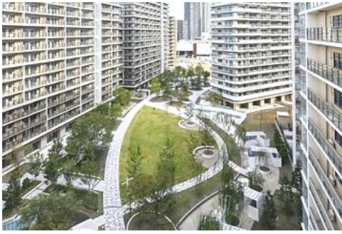
Рис. 7. Комплекс олімпійського містечка, який побудовано за допомогою крупнопанельної технології будівництва. Лондон.
