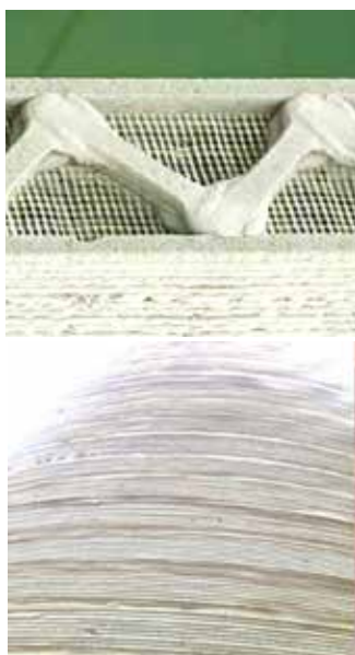
Рис. 2. Склеювання та прокладення пластикових сіток між 2 панелями
