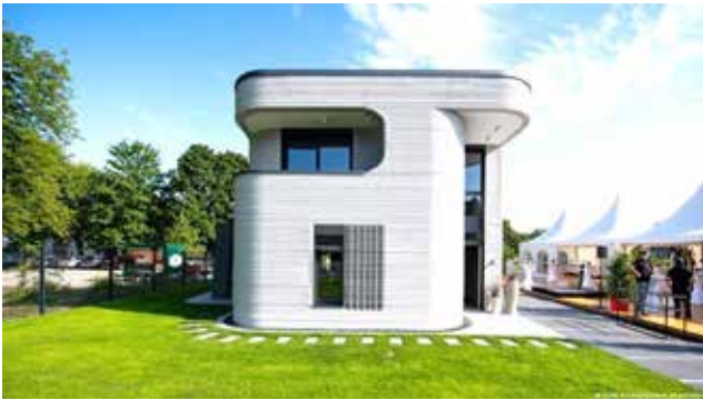
Рис. 9. Побудований будинок роботом-3D-принтером
