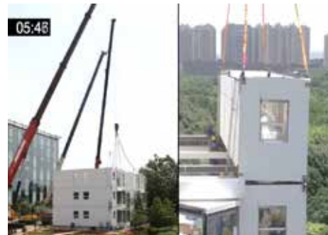
Рис. 6. Зведення житлового будинку з модульних блоків. Китай
