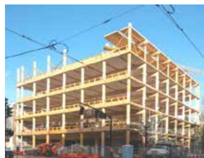
Рис. 4. Дерев'яне каркаспанельне будівництво
