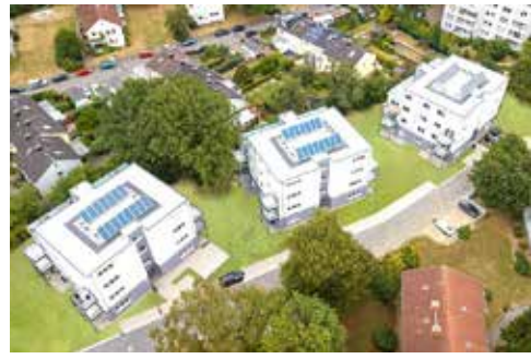
Рис. 8. Комплекс олімпійського містечка, який побудовано за допомогою модульної технології будівництва. Бохум. Німеччина.
