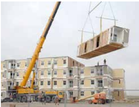
Рис. 9. Спорудження модульного житлового комплексу. Африка
